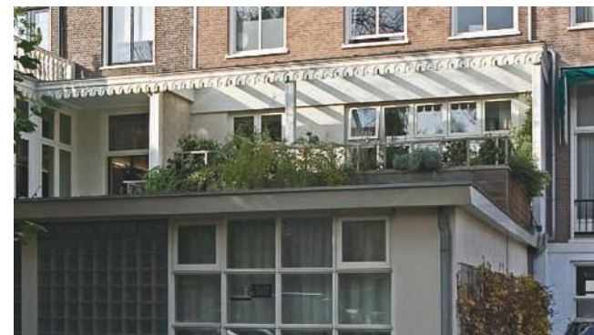
dakterras met sedumdak
