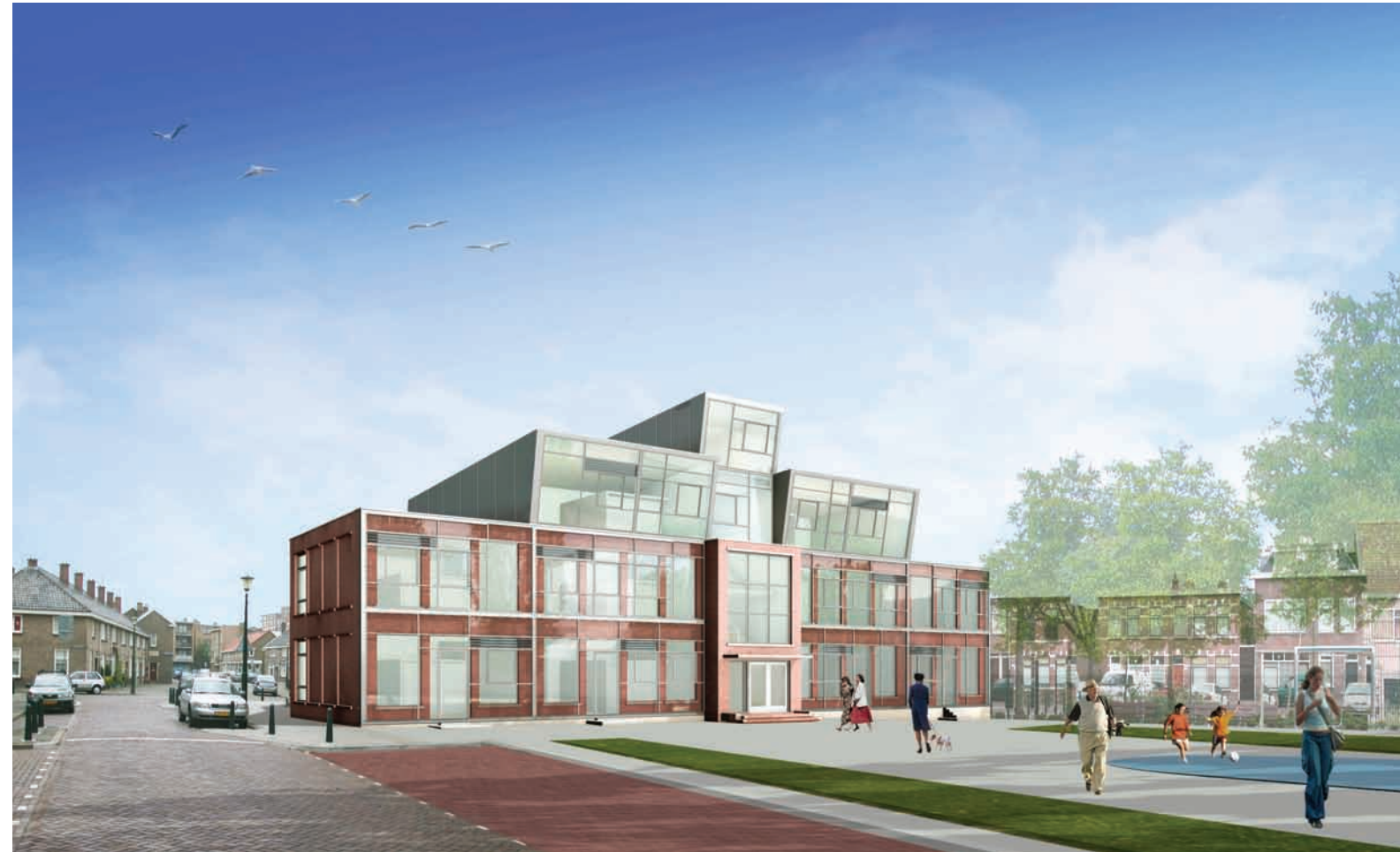
klimaatgevel waar het bestaande metselwerk doorheen schemert
