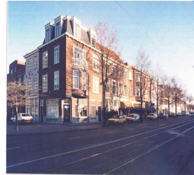
renovatie/restauratie Spui te Den Haag
