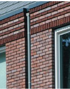
hwa in metselwerk
